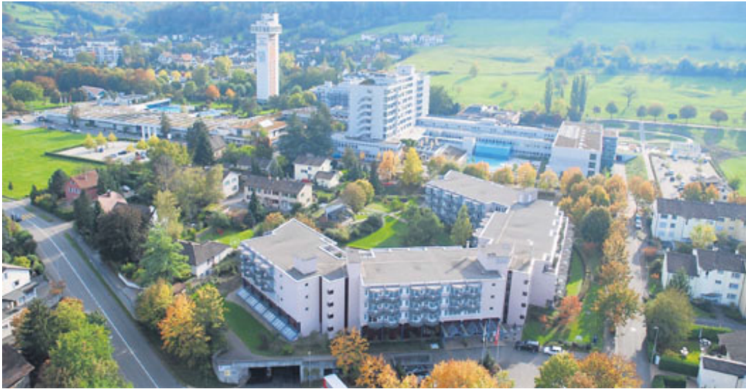
Alles erreichbar in kurzer Gehdistanz, bei schlechtem Wetter auch unterirdisch: Die Thermalbäder, die Rehaklinik und - im Vordergrund - das Park Hotel in Zurzach. René Lang
